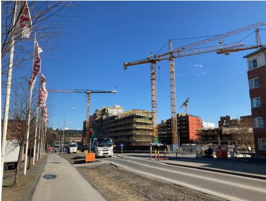
Bildet over er fra byggingen ved Triaden
